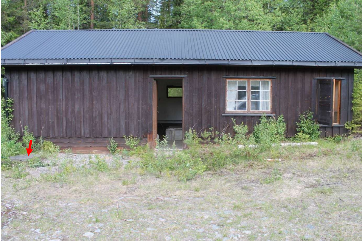
Bilde 1: Slamavskiller med overbygg. Overløpskum til venstre, se pil.
