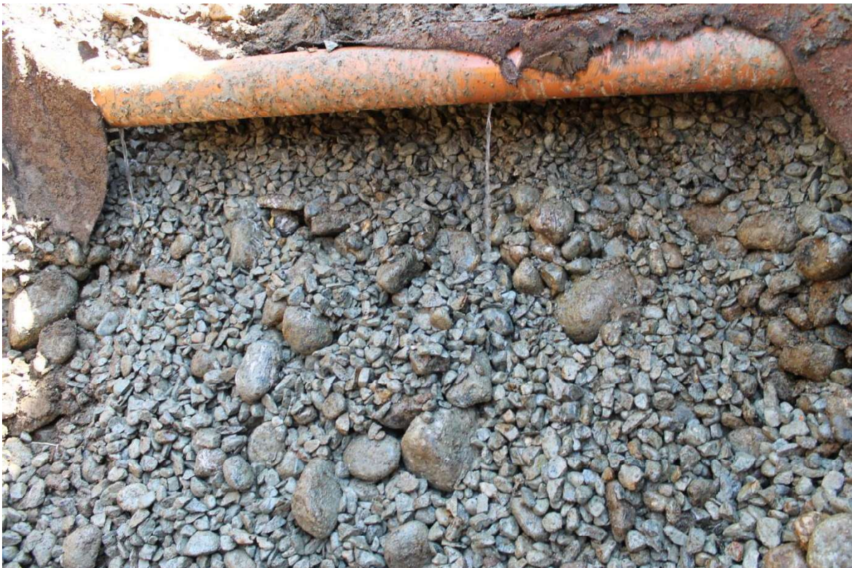
Bilde 6: Sprederør og fordelingslag. Etter at 2 utløpshull er åpnet.
