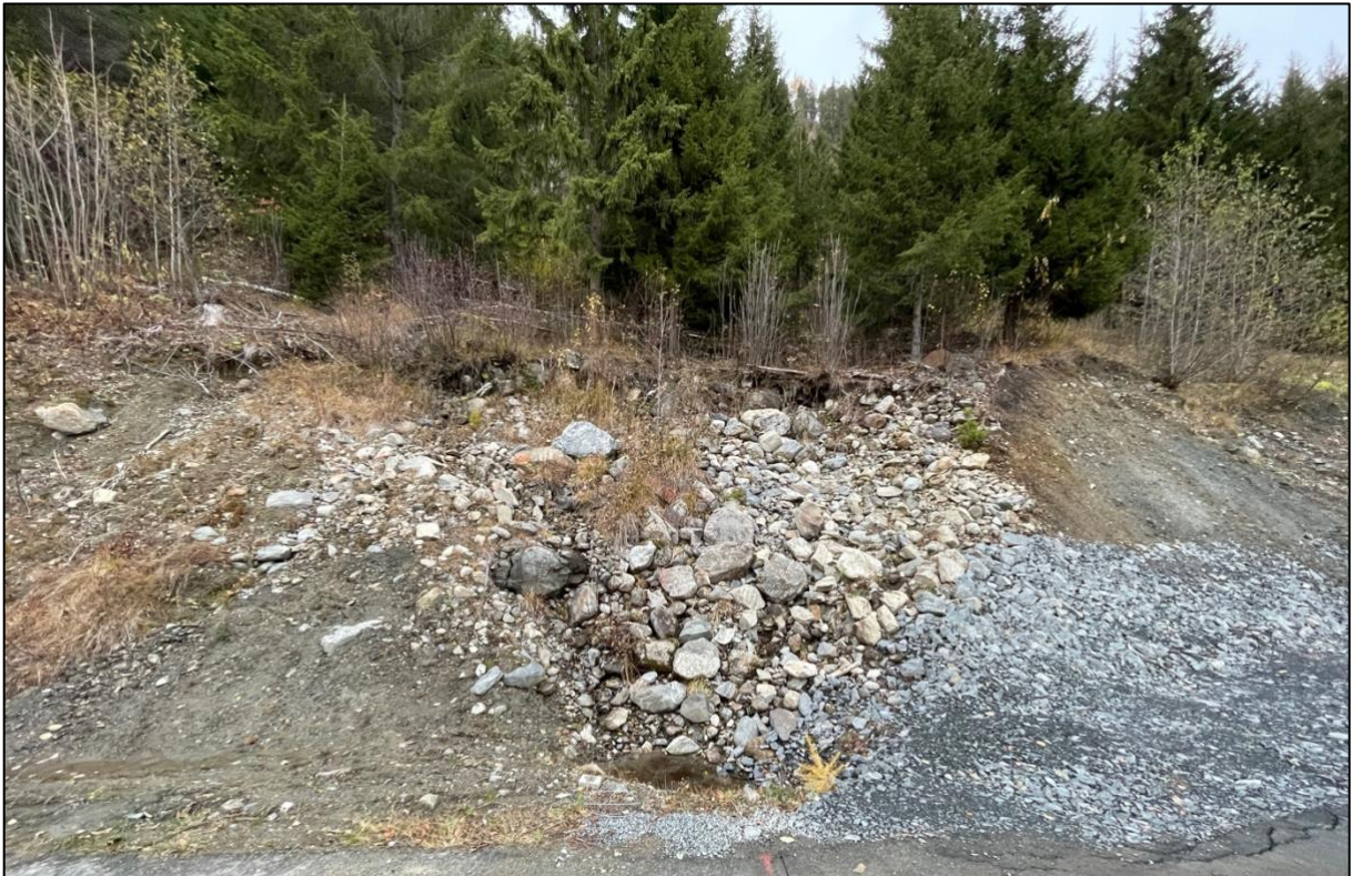
Figur 14: Kileform med rundede blokk i en løsmasseskjæring vest i kartleggingsområdet.
