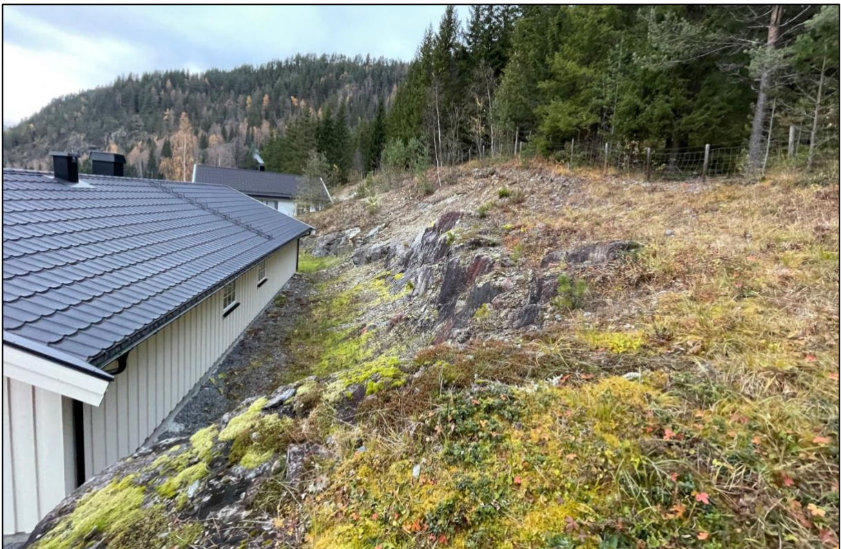
Figur 12: En utsprengt bergskjæring bak en bolig øst i kartleggingsområdet. Det er relativt begrenset med løsmasser i terrenget over bergskjæringen.
