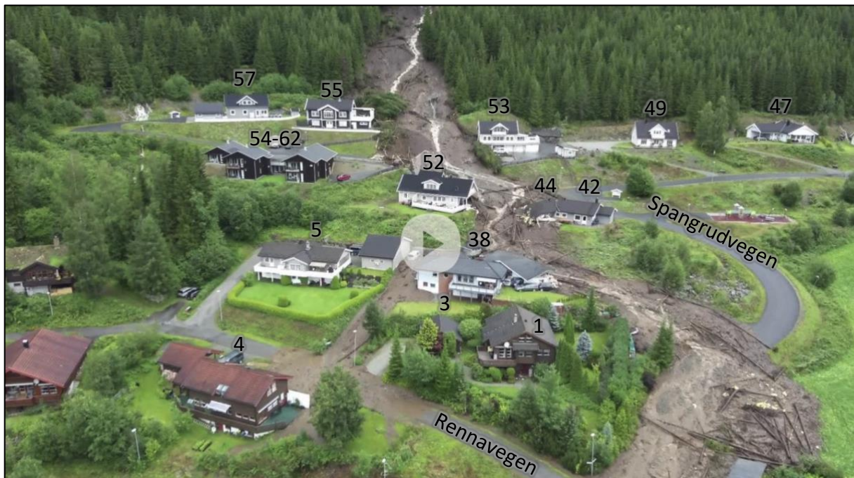
Figur 13: Bilde av skredutløpet inn i boligfeltet. Bildet er hentet fra video tatt av Politiet, gjengitt fra (NGI, 2023). Adresser vist på figuren. Spangrudvegen 23-25 er utenfor bildet.
