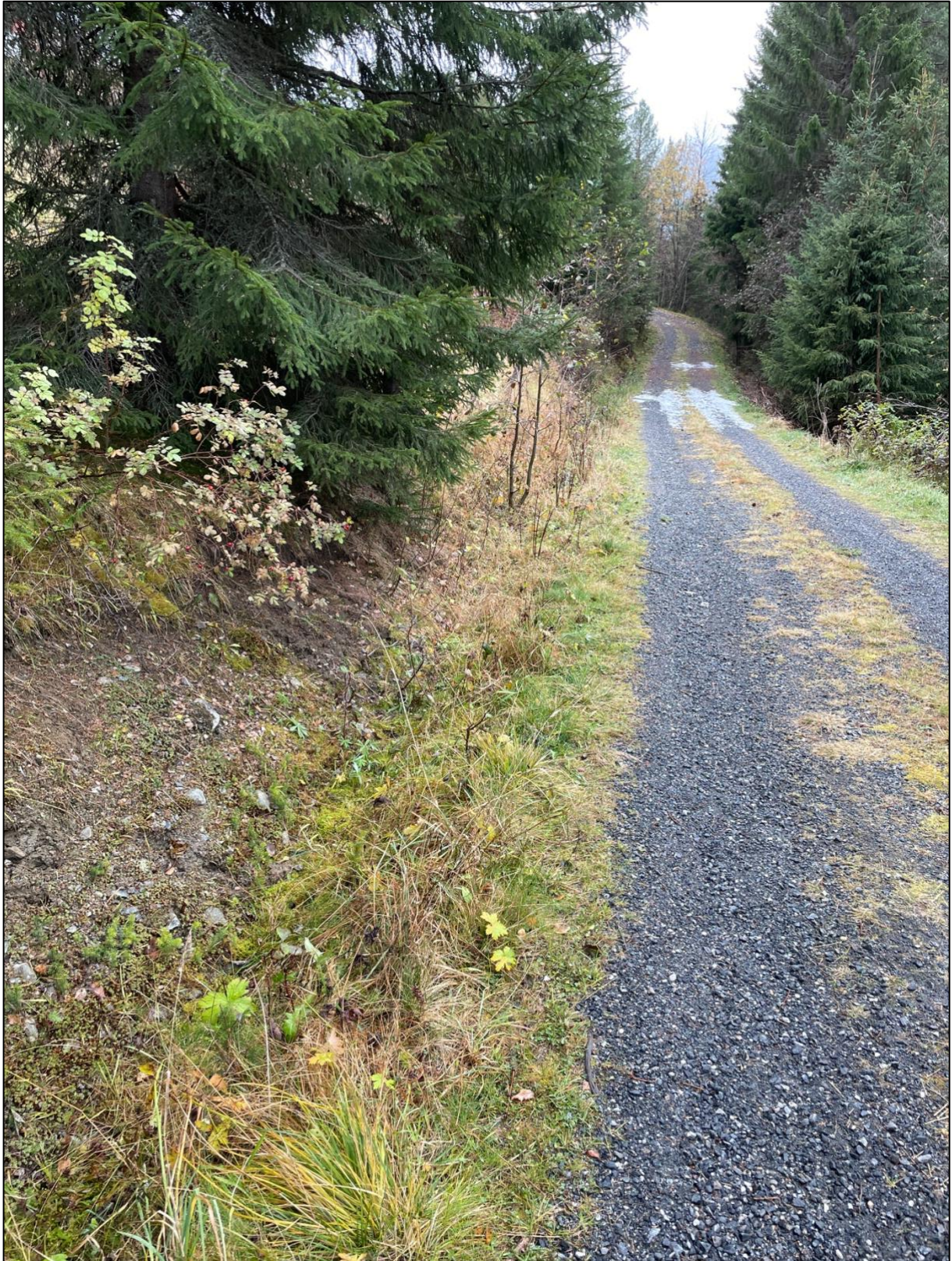
Figur 9: Adkomstveg til Søre Gubberud. Vann ledes i grøft til venstre for vegen.
