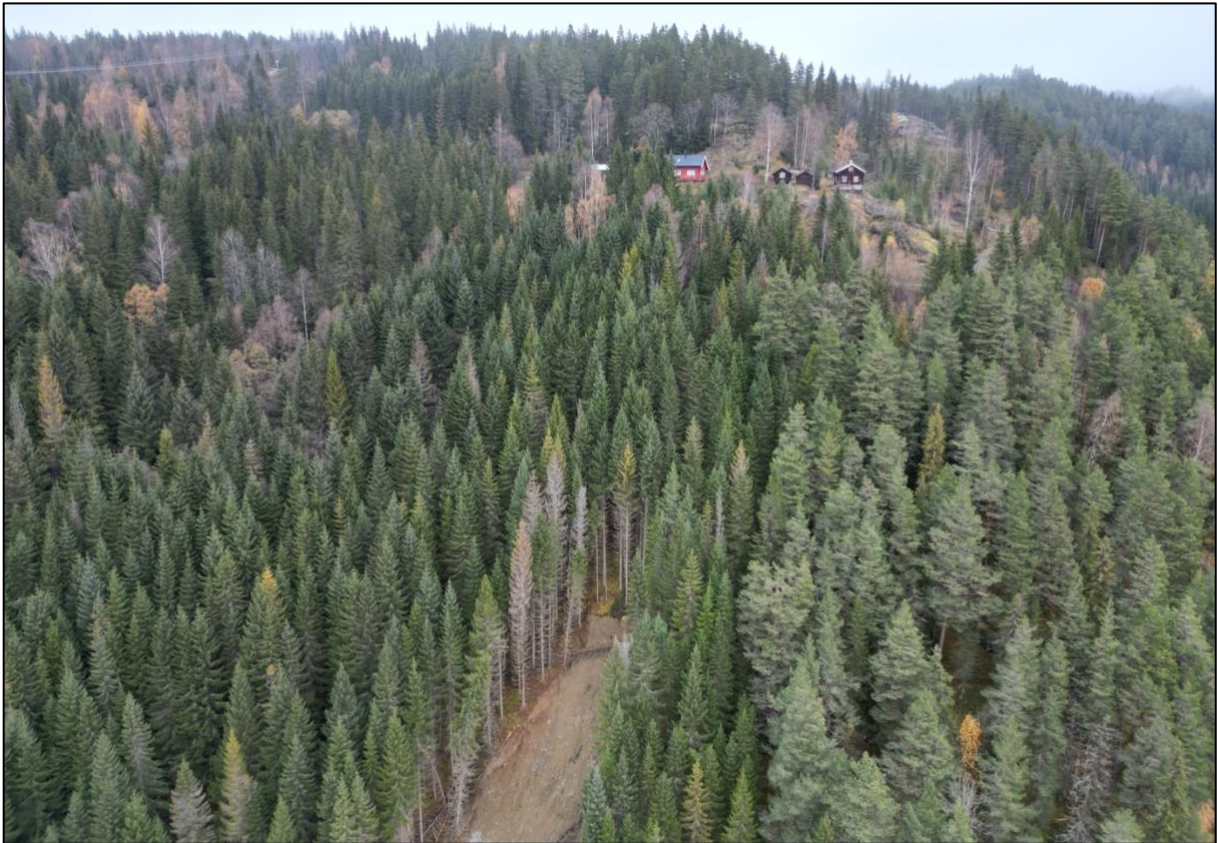
Figur 2: Øvre del av skråningen over skredet ved Søre Gubberud. Dronebilde tatt mot NØ.
