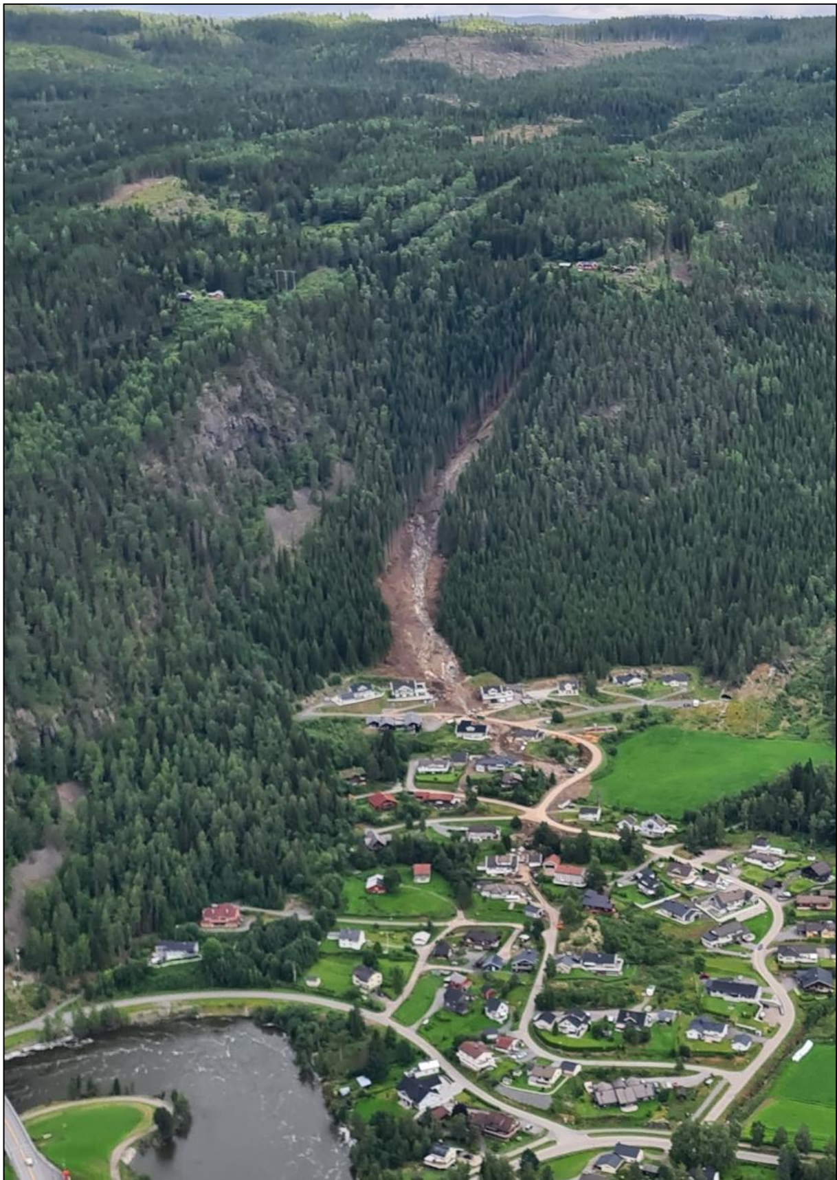
Figur 1: Utsnitt fra helikopterbilde tatt av NVE den 16. august som viser skredet under Hans.
